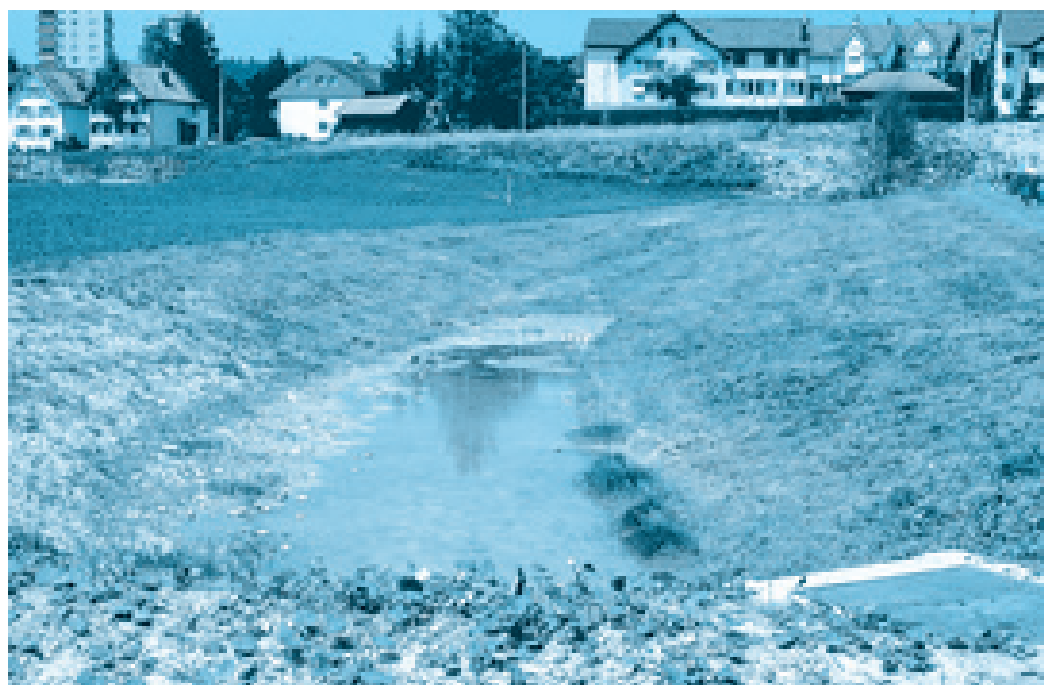
Humusiertes Retentions- und Versickerungsbecken
