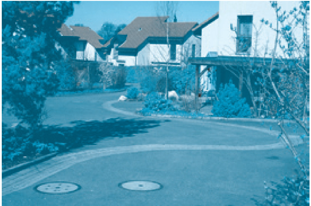
Abflussrinne als Gestaltungselement im Strassenbereich
